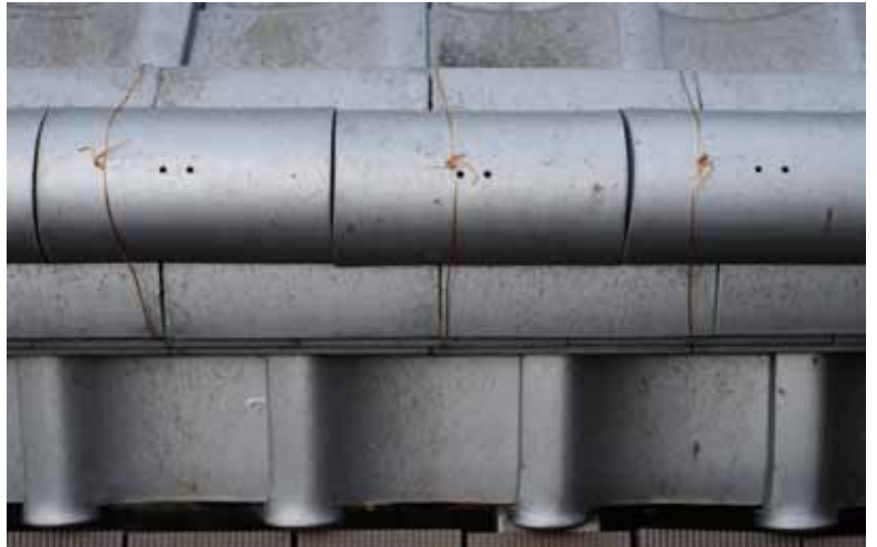
突出看板 / H450×W450×D100mm ベース：アルミ 表示：瓦葺きの屋根は銅線を使って固定している。 乳半アクリル
